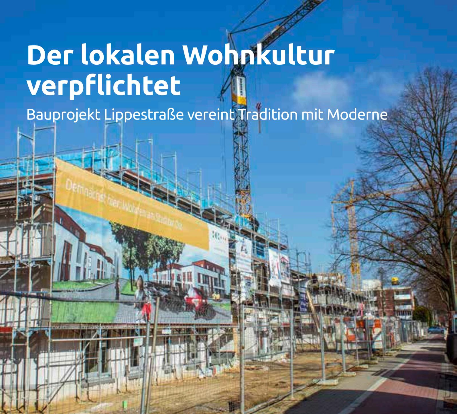
■ Es geht voran am Stadttor Ost: An der Lippestraße stehen die ersten Rohbauten. Das gilt vor allem für die Hausnummer 5. Dort haben die Ausbauten bereits begonnen, erste Fenster wurden eingesetzt. Nun sind Heizung, Sanitär, Wasserleitungen an der Reihe. Das Haus mit der Nummer 7 besitzt Keller und 1. Obergeschoss. Auch an der Jägerallee 56 sind bereits die Keller in Arbeit, teilte Bauleiter Engelbert Ehle während eines Gesprächs Mitte Februar mit.
